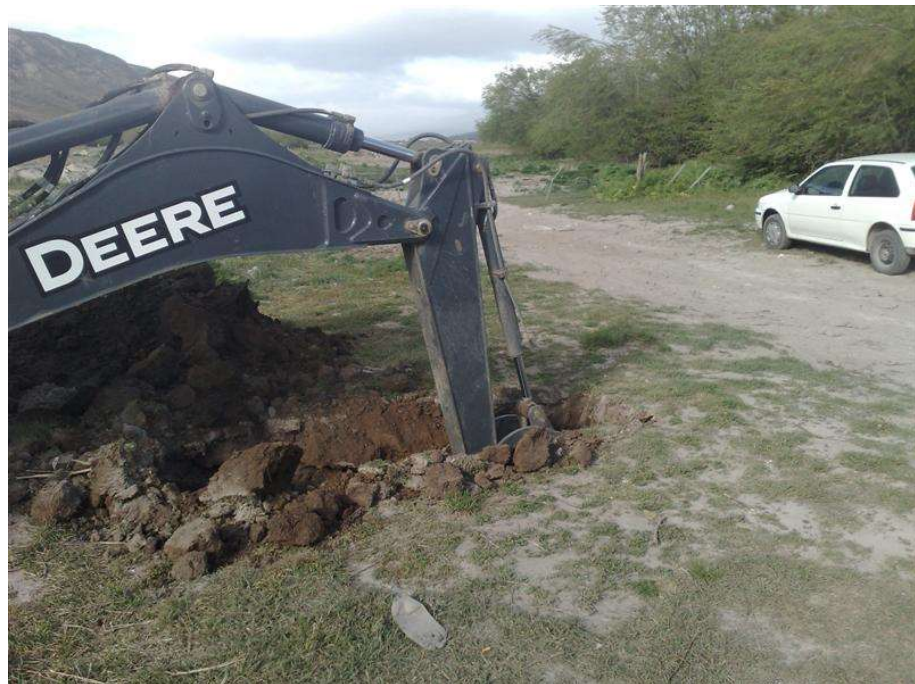
Foto 21. Ejecución Calicata N° 1
