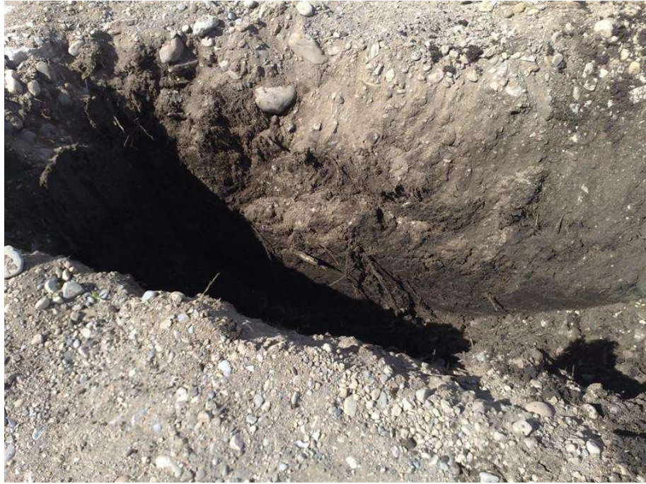
Foto 26. Ejecución Calicata N° 6
