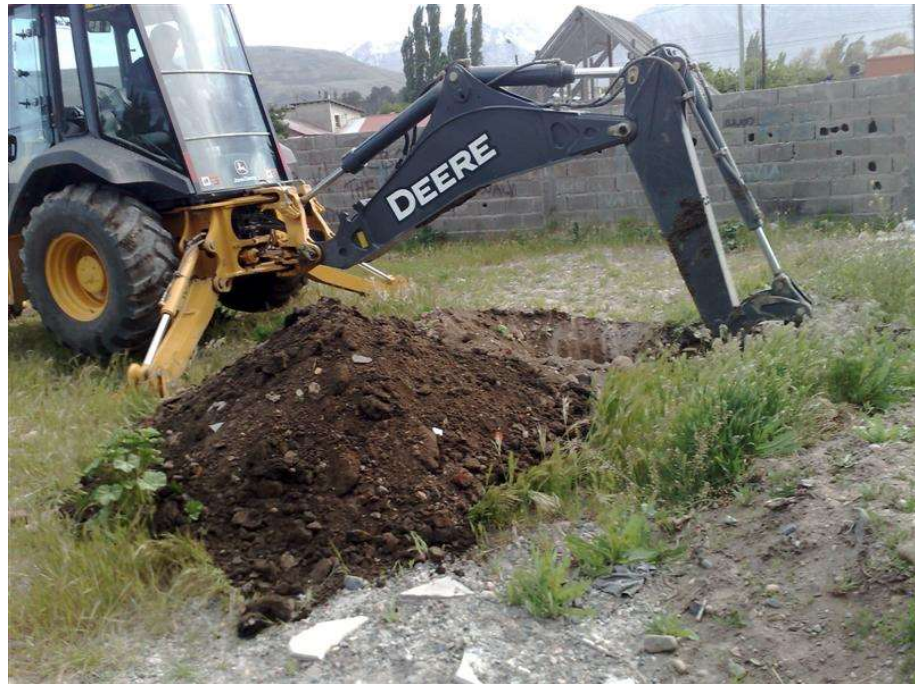
Foto 24. Ejecución Calicata N° 4
