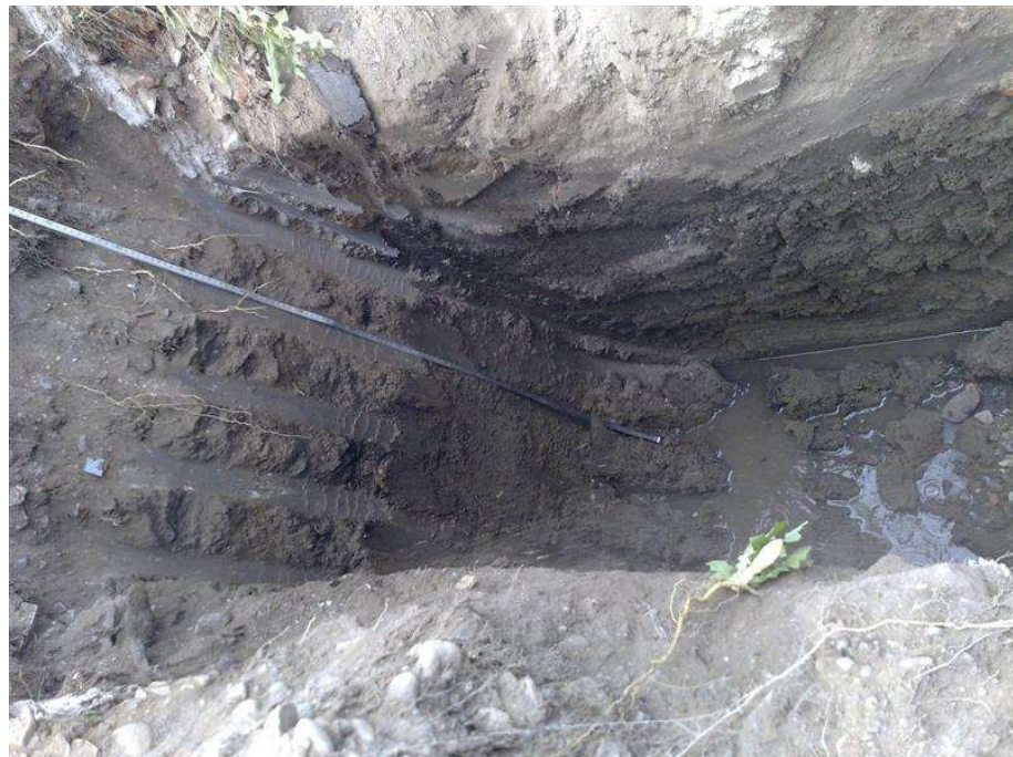
Foto 25. Ejecución Calicata N° 5
